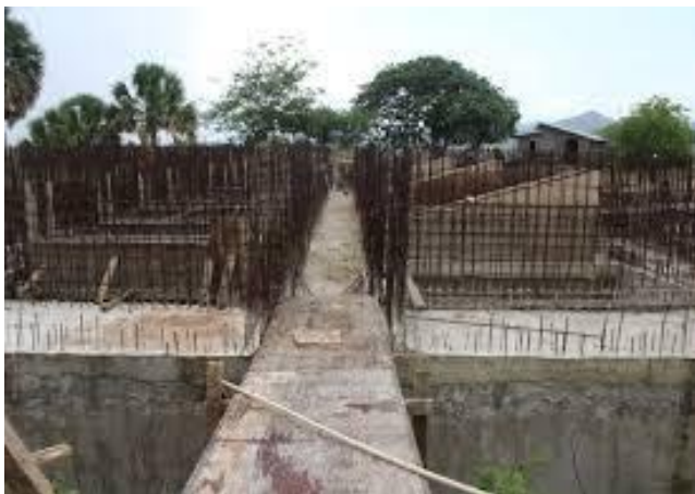
Construcción Planta de Agua Potable de Partido
